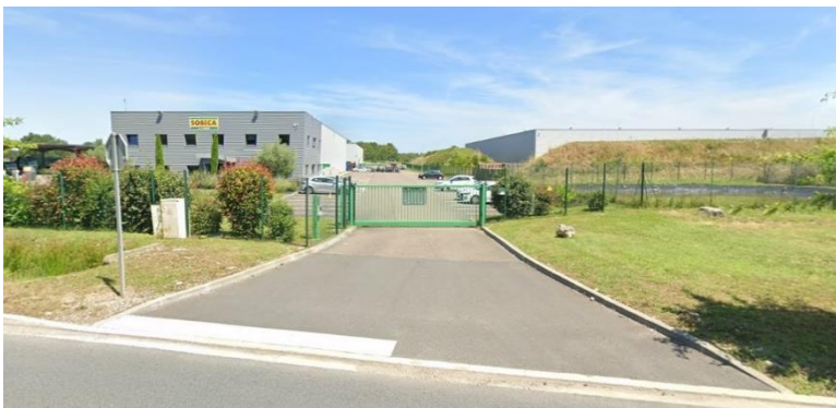
Exemple d'accès borduré
